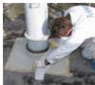
3. Commencer par étancher les détails avec Triflex ProDetail.
