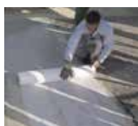
5. Poser le non-tissé spécial Triflex Voile de renfort sur toute la surface en éliminant toutes les bulles.
