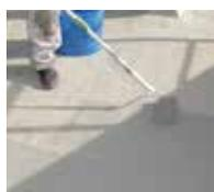
7. Si nécessaire, appliquer la couche de finition au bout d'environ 1 h.
