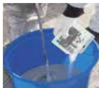
2. Avant application, ajouter Triflex Catalyseur dans la résine.
