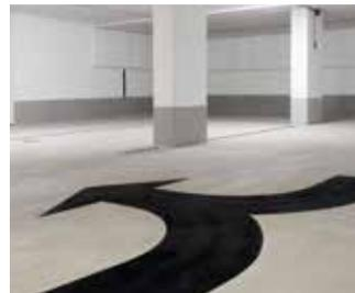
Dank Quarzsandeinstreuung besitzt die Beschichtung eine dauerhafte Griffigkeit. Farbliche Gestaltungselemente dienen zur Orientierung und Verkehrssicherheit.
