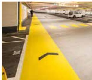
An den Rampen und Spindeln, die täglich hohen Schub- und Scherkräften ausgesetzt sind, wurde das OS 10-Abdichtungssystem Triflex ProPark eingesetzt. Ebenfalls vollflächig vliesarmiert, sichert der durchgehende Einsatz des Werkstoffs PMMA den hinterlaufsicheren Verbund. Aufgrund des geringen Flächengewichts des Systems kann dieses auf nahezu allen Untergründen eingesetzt werden, ohne die Statik zu beeinflussen.
