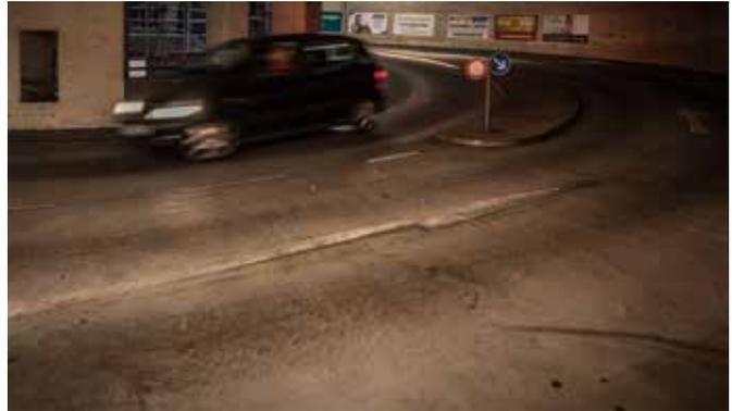
Chloride aus Tausalz hatten über die Jahre am Untergrund Schäden hinterlassen, durch die Feuchtigkeit in die Betonkonstruktion eindringen konnte. Um eine Vollsperrung zu vermeiden und den Zeitaufwand gering zu halten, war es wichtig, dass die neue Beschichtung auf dem Altbelag haftet.
