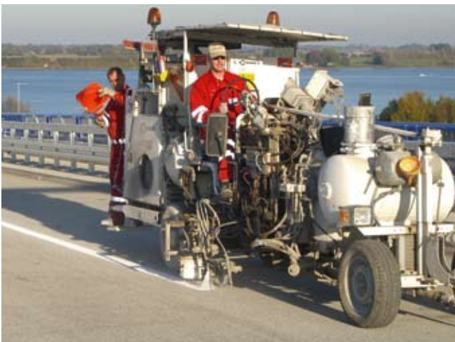
Innerhalb von nur zwei Tagen mussten die Hauptmarkierarbeiten mit Leitlinien durchgeführt werden.
